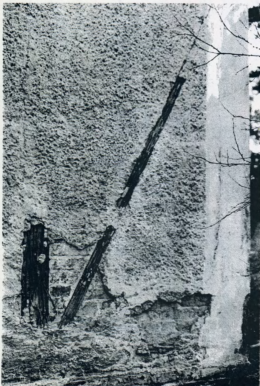
Fasad (korsvirke, tegelfyllnad och puts)
