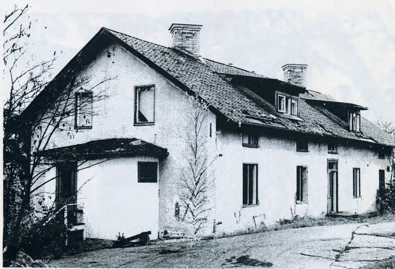
Långfasad mot söder, gavelfasad mot väster.
